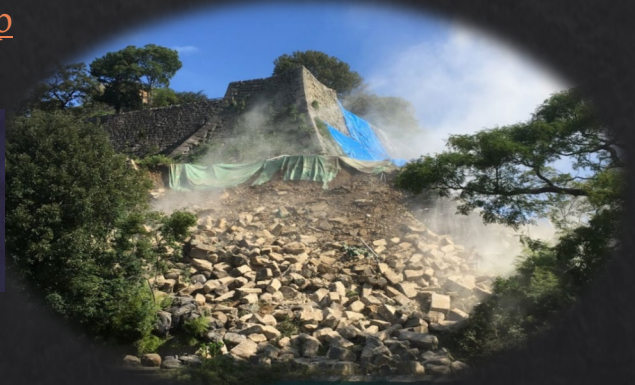
丸亀城帯曲輪の石垣崩落状況 (丸亀市 提供)
