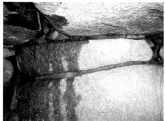
図3 大坊古墳における目地の粘土状物質 Fig.3 Clay between stones at Daibo Tomb.
