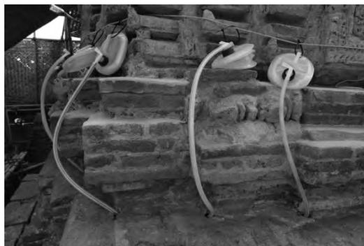
写真1 寺院内部の目地材の補強 (Consolidation 8020)
