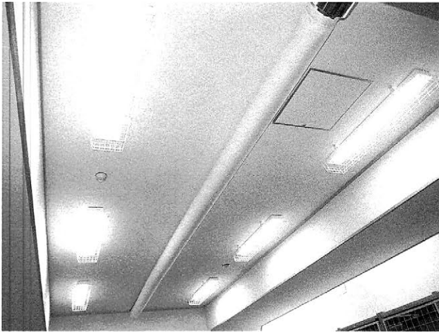
写真4 特定の吹出し口を設けず、空調機からの送風を広範囲で均一化するソックダクト
