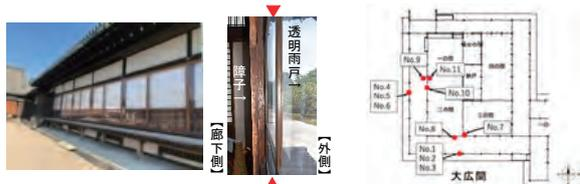
写真1 透明雨戸とその空気層 図1 温湿度計設置位置
