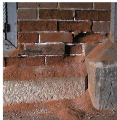
図1 富岡製糸場の粉状化煉瓦
