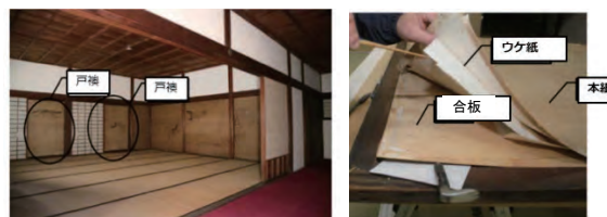
写真1 戸襖の設置状況（左）と戸襖構成（右）
