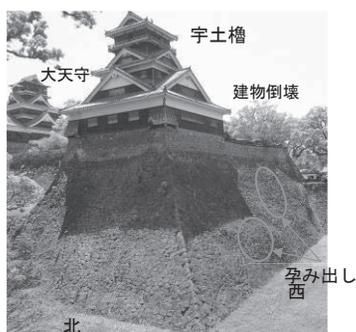
図-1 宇土櫓の被災状況
