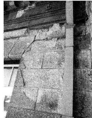
写真2 旧日本郵船の西壁面劣化
