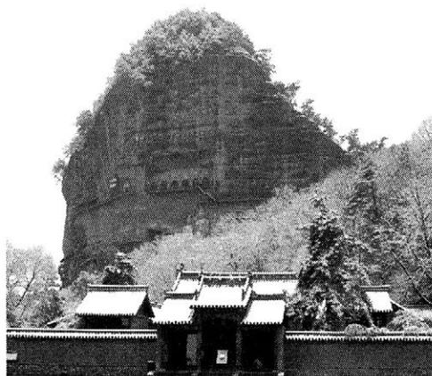
その結果、麻の配合比や合成樹脂の種類により特性が見られ、修復対象となる個所の部位や環境に即した材料の選択基準を見出すための知見を得ることができた。また、石窟内では浸出水により岩体の崩落が問題となっている。そこで水溶性の樹脂を用いての崩落止めをおこなった。未処理と比較し崩落量が1/10以下に抑えることができるなど、高い効果を得ることができた。
